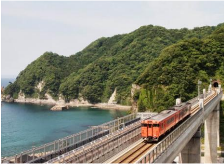
餘部橋梁 空の駅（海側）
